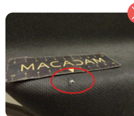
Quemadura revestimiento puerta
