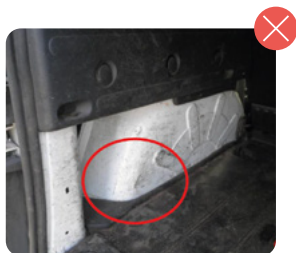
Abolladura zona de carga
