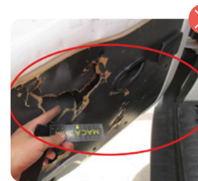
Panel zona de carga roto
