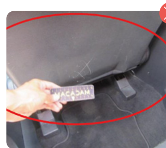
Arañazos revestimientos Asientos o consolas traseras
