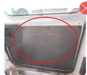
Panel zona de carga roto
