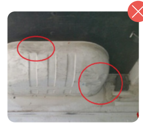
Abolladura zona de carga
